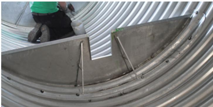
7f. Insérer les boulons d'ancrage avec la tête et l'écrou à l'intérieur du ponceau. Assurez-vous d'avoir une rondelle à l'intérieur et une à l'extérieur.
