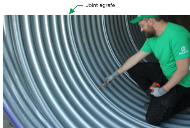
6b. S'assurer de ne pas positionner les boulons d'ancrage dans le **joint agrafe**.
