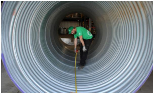
6a. Mesurer l'emplacement du premier déversoir à installer, conformément aux exigences du Tableau 2 de l'[Annexe 10](#) du RADF.
