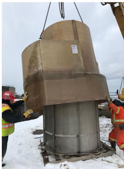
6. Tout en retenant le cylindre de séparation en fibre de verre (avec la grue ou la pelle mécanique), se positionner en dessous de la partie en fibre de verre. Ajuster les deux éléments, percer un premier trou dans la fibre de verre et y boulonner la grille de séparation. S'assurer que la grille de séparation est toujours centrée avant de passer au trou suivant. Serrer solidement les boulons et les rondelles de blocage.
