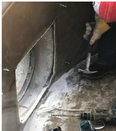
11. Appliquer un cordon d'étanchéité en élastomère de polyuréthane (joint de butyle) et terminer l'étanchéité avec le Sikaflex 1a pour sceller l'espace entre la fibre de verre et la paroi de la structure de béton du regard.
