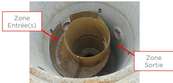
9. Découper la fibre de verre aux ouvertures d'entrée. Porter une attention particulière pour ne pas endommager le plancher en fibre de verre.
