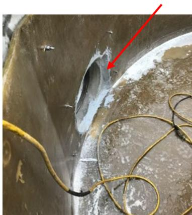
12. Ancrer la base de la grille de séparation à la dalle de séparation de béton.
