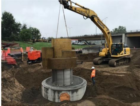
8. Positionner la zone d'entrée de l'assemblage vers les ouvertures d'entrée en s'assurant de l'appuyer contre la paroi intérieure du regard.
